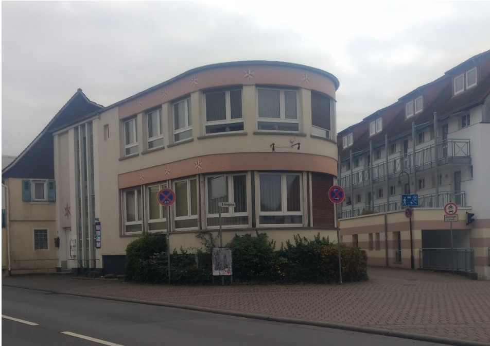
Bild 1 Urberach: Traminer Straße (vor ehemaligem Gasthaus „Zum Stern“), rechts Einfahrt in Erlengasse
